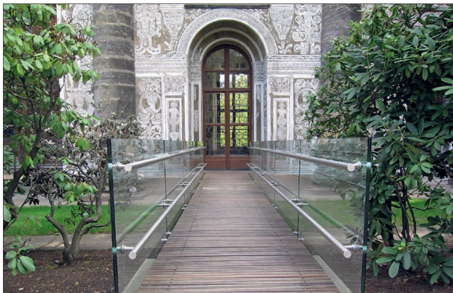
Obr. 8: Příklad trvalého způsobu zajištění bezbariérového přístupu. Most, který překlenul snížený terén před Míčovnou Pražského hradu, umožňuje nyní i návštěvníkům na vozíku bezbariérově vstupovat do jejího interiéru. (Foto M. Jančo)
