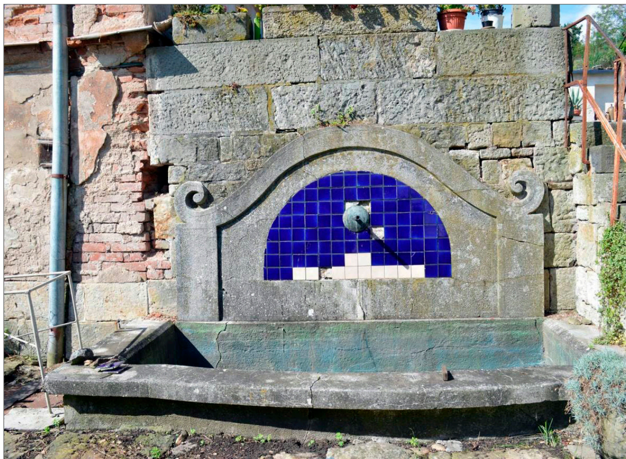
Obr. 14: Zachovalá okrasná nástěnná studna s formálním bazénem. Foto H. Gálová, 2015. Archiv Ústavu biotechniky zeleně ZF MENDELU.
